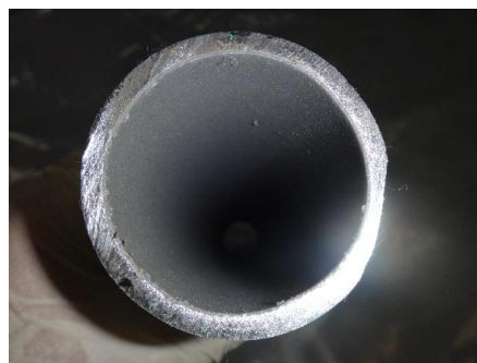
排水管内部剥離後
