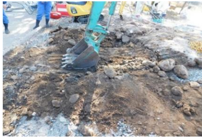
図 19 張芝工（整地工）
