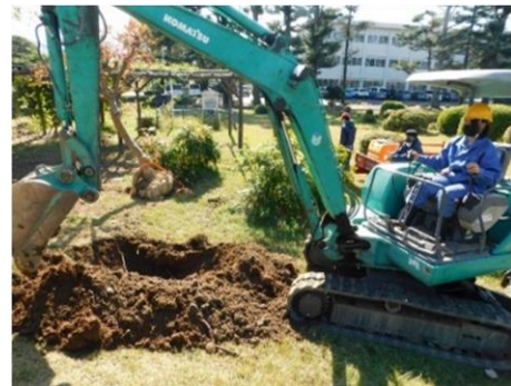
図 17 サルスベリの移植工 (植穴掘り)
