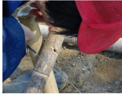
図 15 シダレザクラの植栽 (支柱工)
