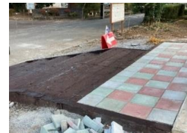
図 8 階段部分完成
