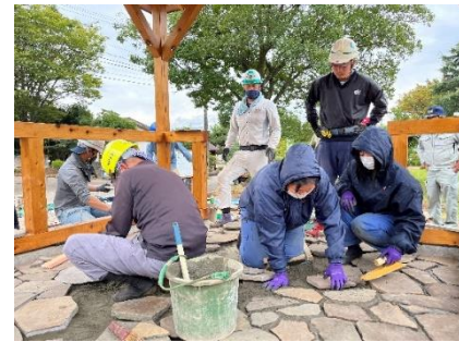
図 6 石張工（鉄平石を敷き）
