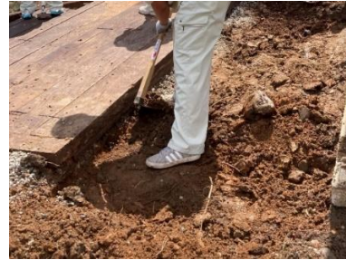
図 5 最上段掘削作業
