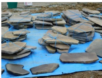
図 4 石張工（鉄平石材料）
