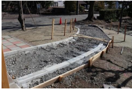
図 10 スロープ縁石設置
