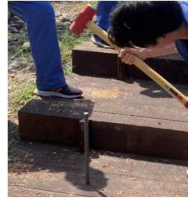
図 4 アンカー打設作業
