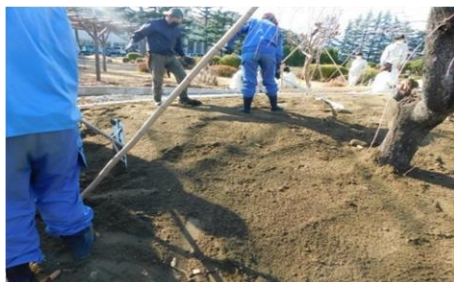
図 23 張芝工（表土面仕上げ工）
