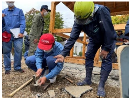
図 7 石張工（鉄平石を割る）
