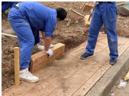
図 3 踏板設置作業
