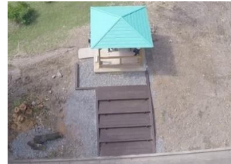
図 6 階段木部・コンクリート平板枠完成
