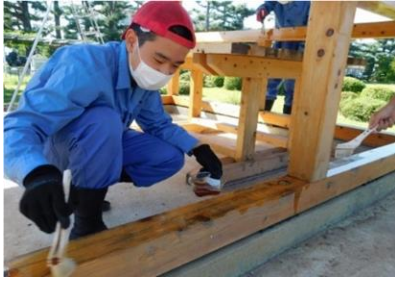
図 10 建屋の点検 (四阿の表面のニスの再塗装)
