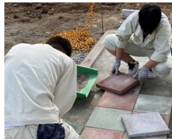
図 7 コンクリート平板敷設作業
