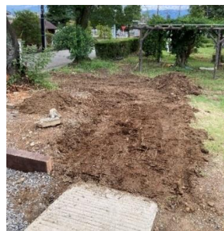
図 9 スロープ着手 基礎掘削
