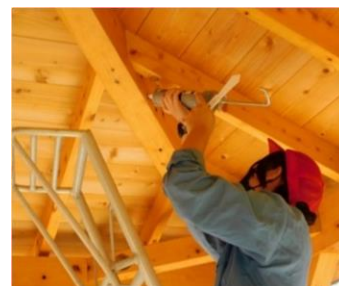
図 9 建屋の点検 (屋根材の補修強化・シリコン材注入)
