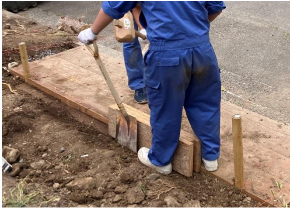
図6 階段施工 止め杭設置
