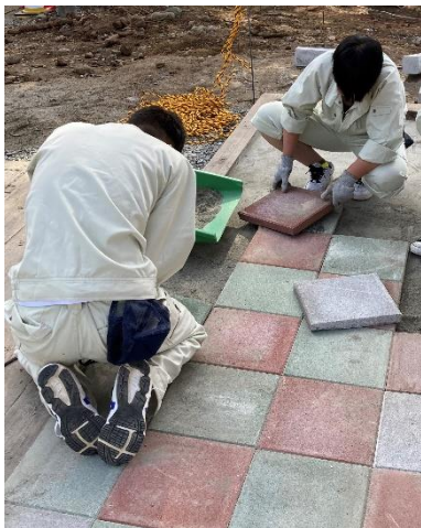
図 18 コンクリート平板敷設
