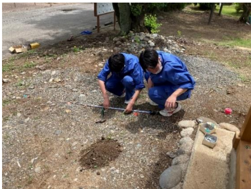
図2 水糸・鋺の設置
