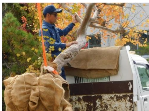
図9 サルスベリの移植工
