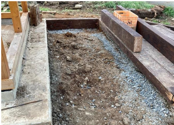
図 13 枠の設置
