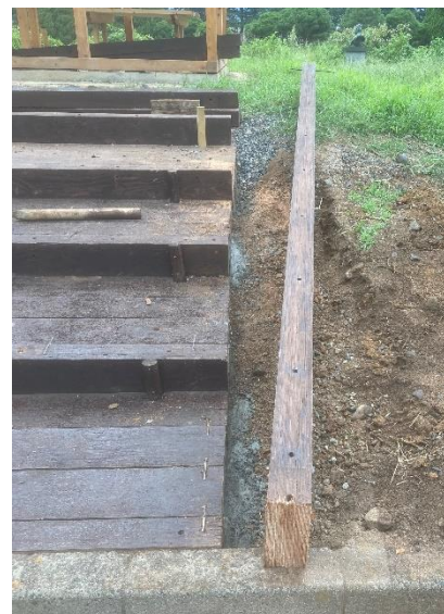
図11 側桁設置
