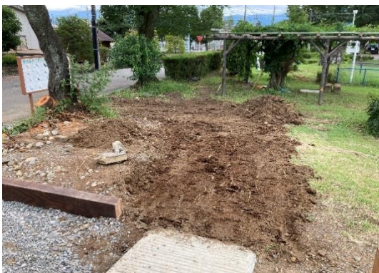
図 21 スロープ基礎掘削
