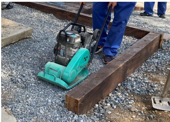
図 14 碎石敷き均し・転圧
