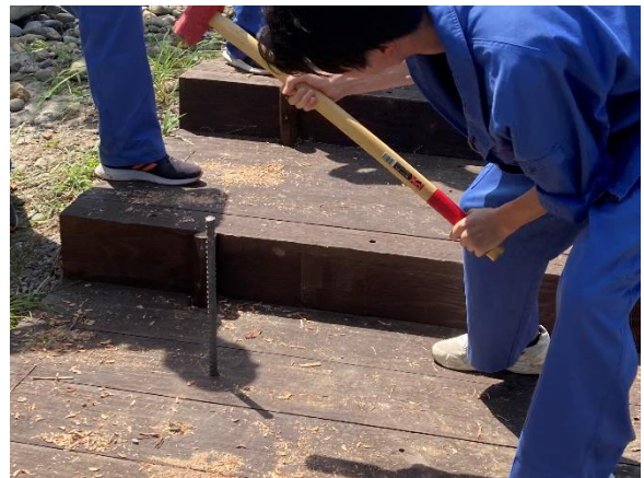
図10 アンカー打設
