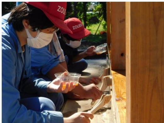
図5 建屋の点検 四阿の表面のニスの再塗装
