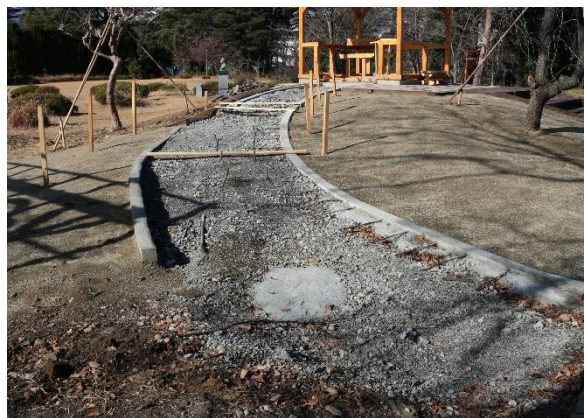
図 23 スロープ縁石片側完成
