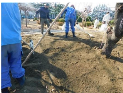
図11 張芝工 表土面仕上げ工
