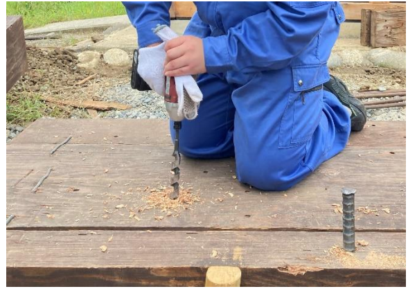
図9 アンカー用穴作成
