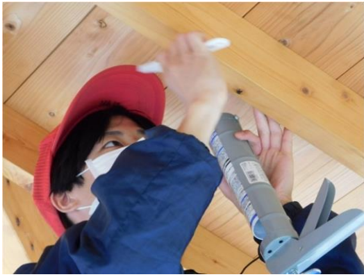
図4 建屋の点検 屋根材の補修強化…シリコン材注入
