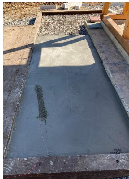
図 17 下地用モルタル打設
