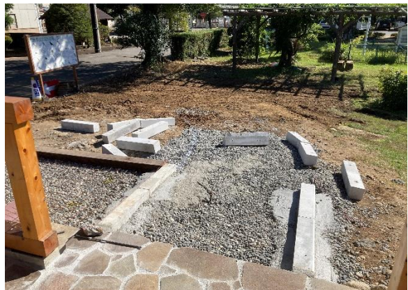
図 22 スロープ縁石設置
