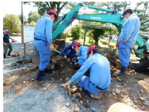
図7 サクラの伐採 抜根作業の様子 イ シダレザクラの植栽工
