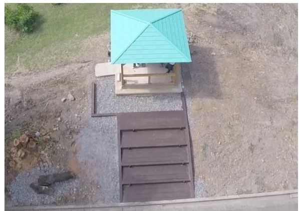
図 16 階段木材部分完成
