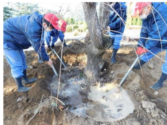
図8 シダレザクラの植栽 水極め ウ サルスベリの植栽工
