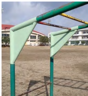
写真 30 開口部を全て埋めた対策例
