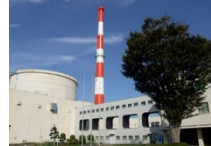
高速実験炉「常陽」
