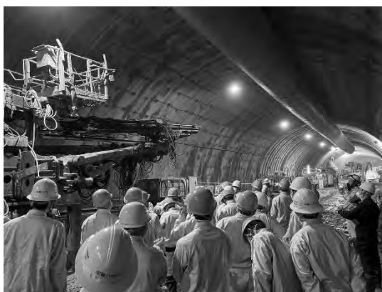
写1) 横堀トンネルの現場説明の様子
