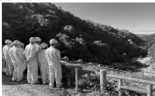
写1) 工事現場見学の様子
