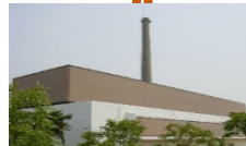
高レベル放射性物質取扱い施設 (CPF)
