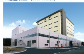
全景 (南西より)
