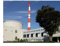
高速実験炉「常陽」
