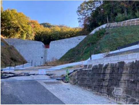
土砂崩れの復旧状況について視察
