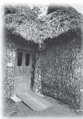
← 出入り口の段差に スロープが設置された チセ（アイヌの住居）
