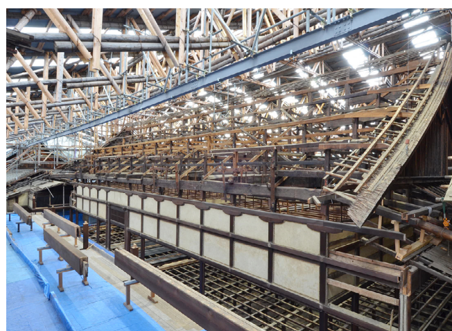
大徳寺方丈及び玄関 屋根解体中（写真提供：京都府）
