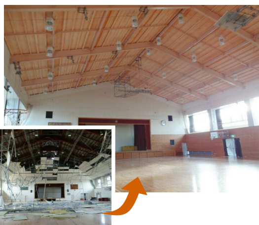
屋内運動場の吊り天井の落下防止対策の例（天井撤去）
