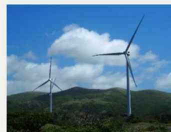
リエネ松前風力発電所 (北海道) 定格容量 : 41MW (2020年3月期運転開始)
