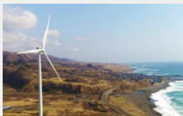
リエネ松前風力発電所
