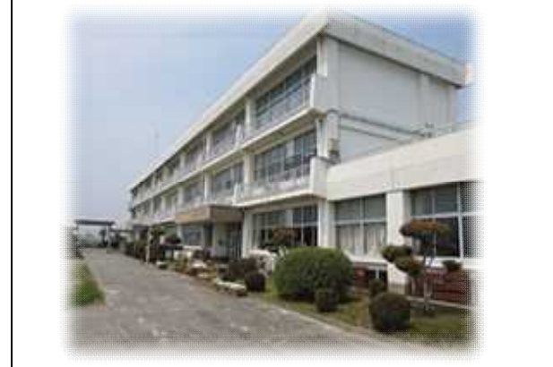
校舎の外観写真
