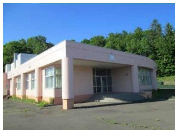
校舎等の外観写真
