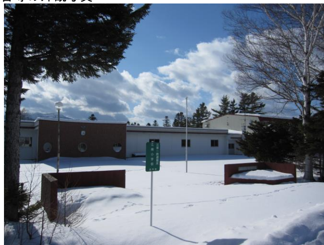
校舎等の外観写真
