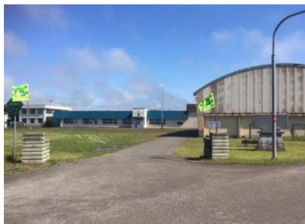
校舎等の外観写真
