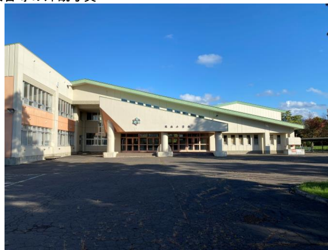
校舎等の外観写真
