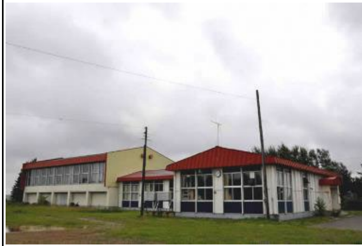
校舎等の外観写真
