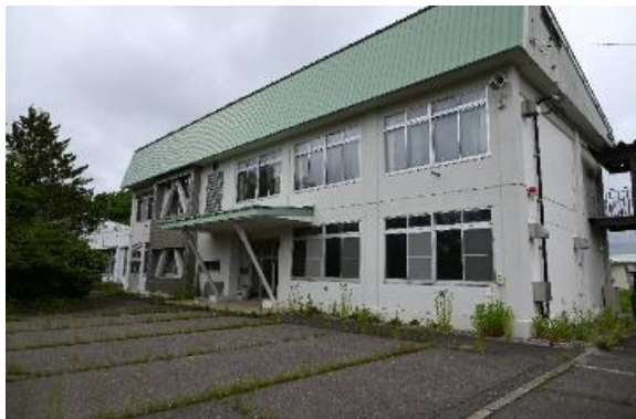
校舎等の外観写真
