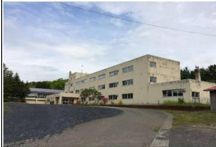
校舎等の外観写真
