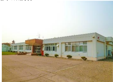
校舎等の外観写真
