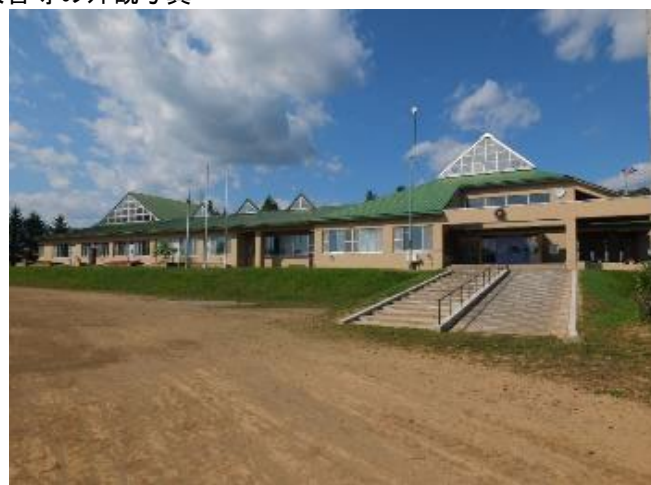
校舎等の外観写真
