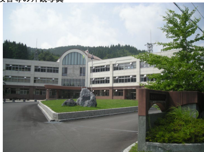
校舎等の外観写真
