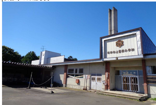
校舎等の外観写真
