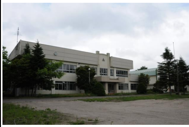
校舎等の外観写真
