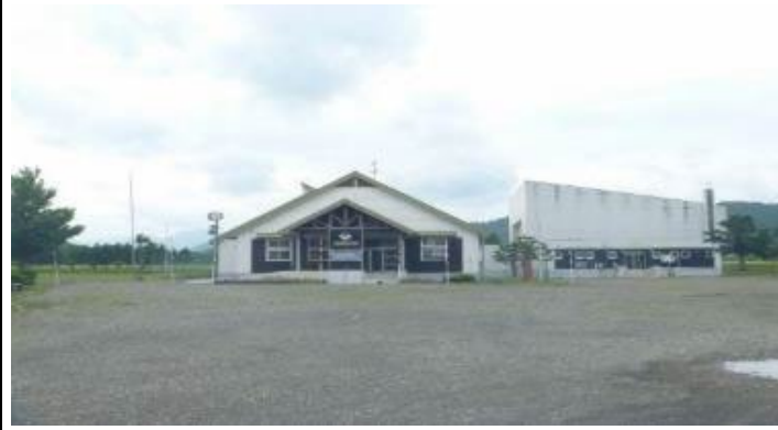
校舎等の外観写真
