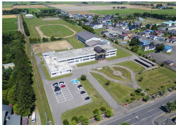
校舎等の外観写真
