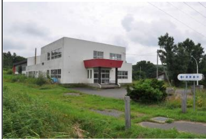
校舎等の外観写真
