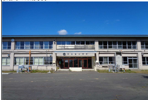
校舎等の外観写真
