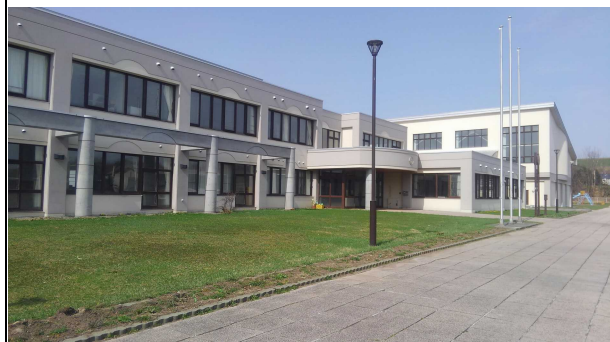
校舎等の外観写真
