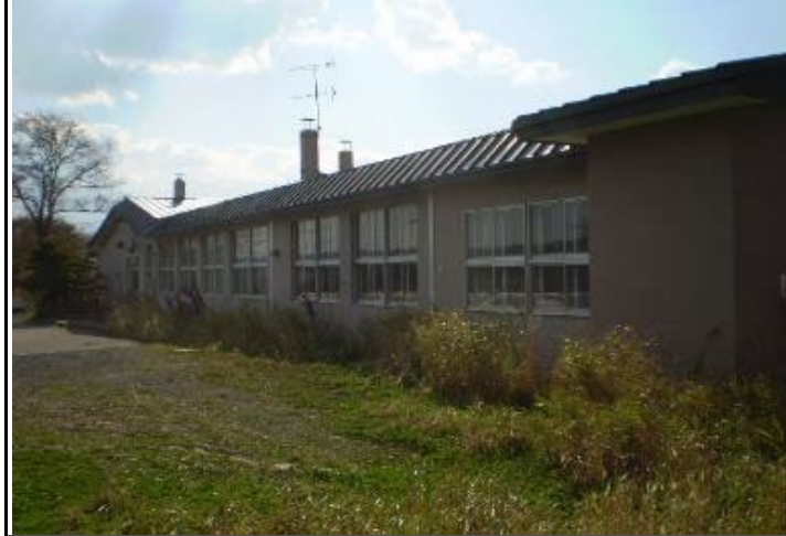
校舎等の外観写真
