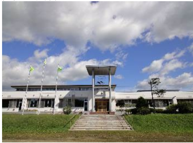
校舎等の外観写真
