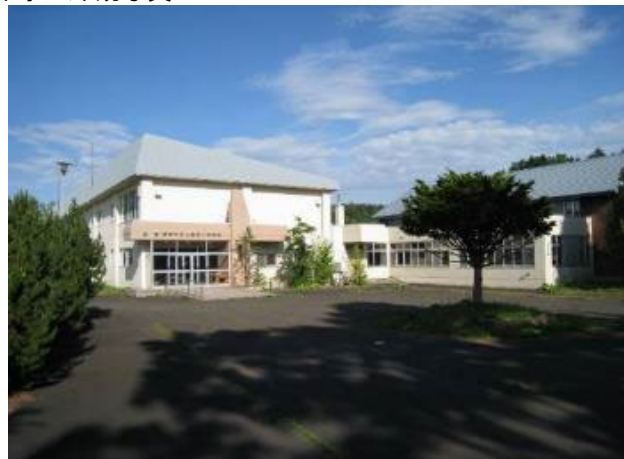
校舎等の外観写真
