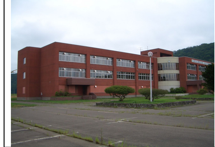
校舎等の外観写真
