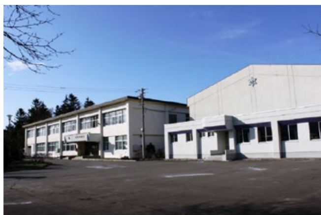
校舎等の外観写真
