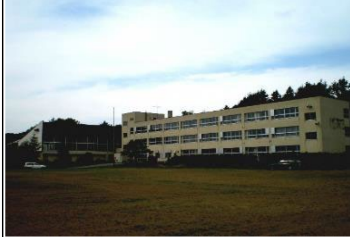
校舎等の外観写真
