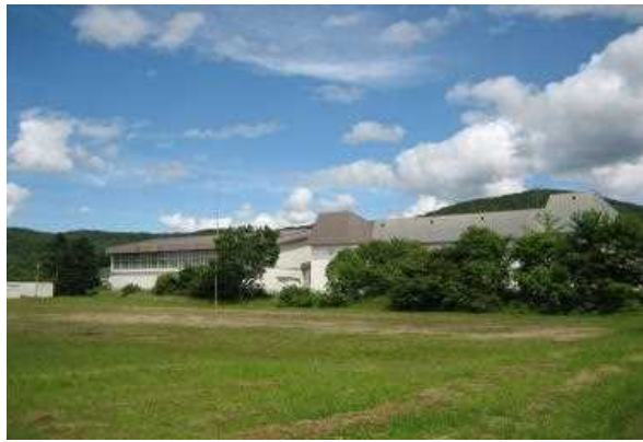
校舎等の外観写真
