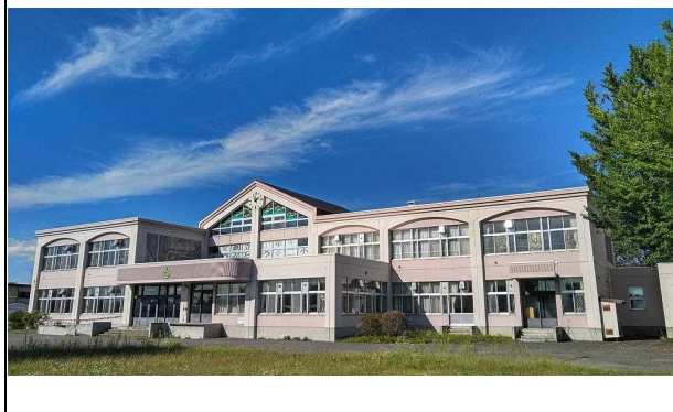
校舎等の外観写真
