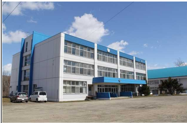
校舎等の外観写真
