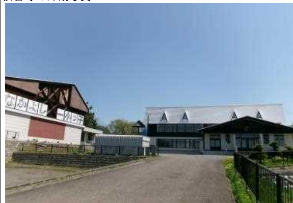
校舎等の外観写真
