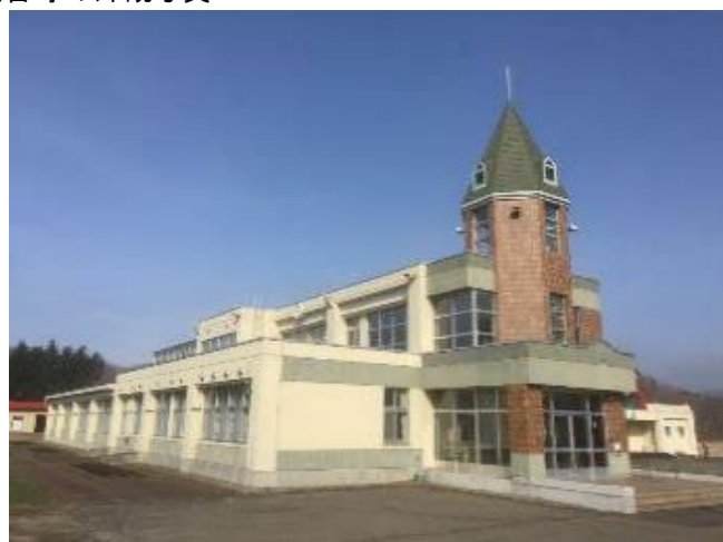
校舎等の外観写真
