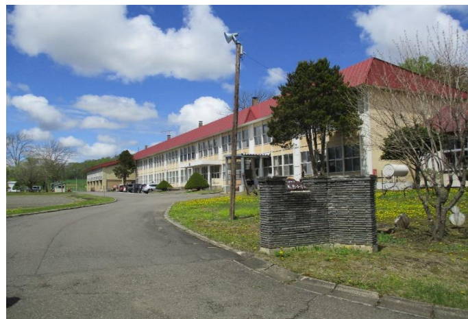
校舎等の外観写真
