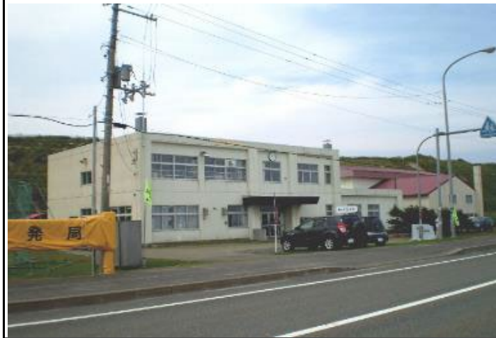
校舎等の外観写真
