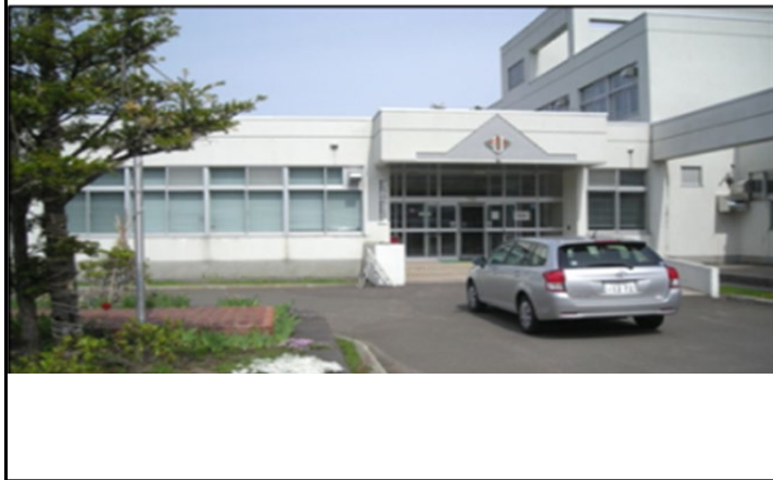
校舎等の外観写真
