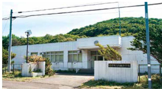
校舎等の外観写真
