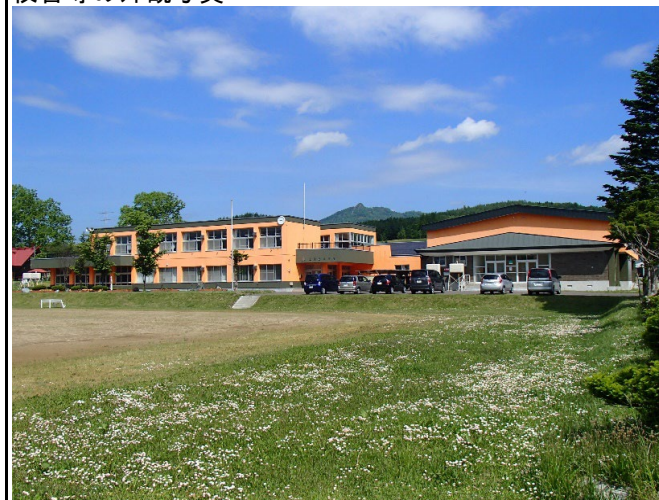
校舎等の外観写真
