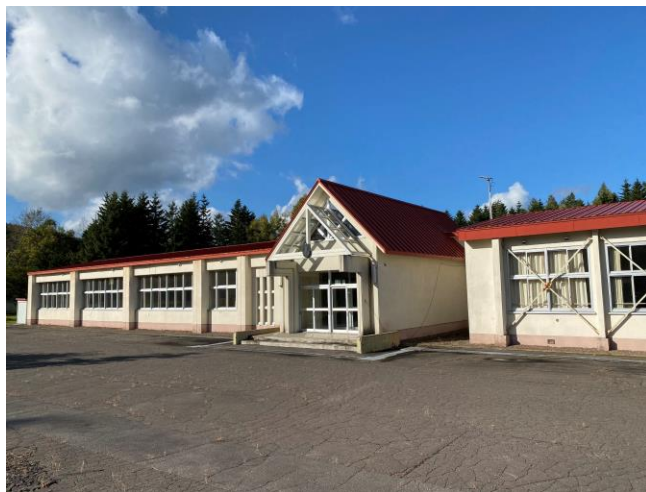
校舎等の外観写真
