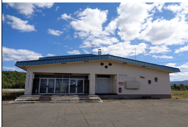
校舎等の外観写真
