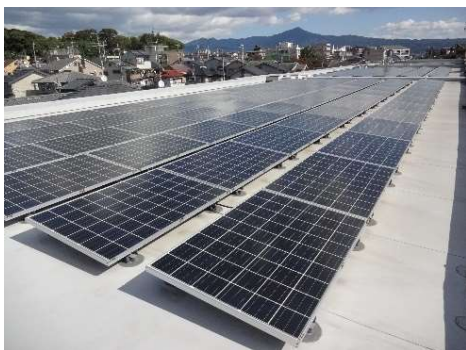
校舎屋上太陽光パネル 438枚設置（設備容量：94.2kW）
