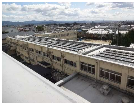
校舎屋上太陽光パネル 438枚設置（設備容量：94.2kW）
