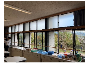
欄間窓のすりガラス
