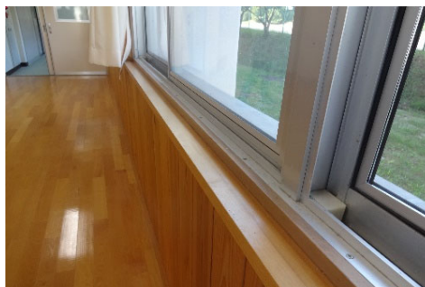
外壁の断熱化（内断熱）
