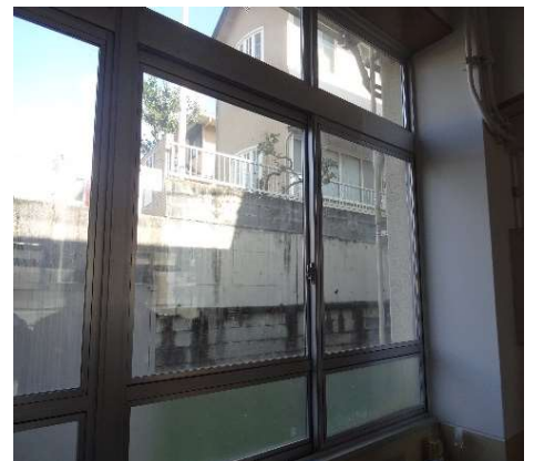
複層ガラスによる断熱化
