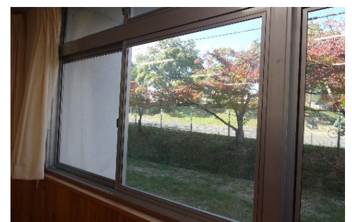
複層ガラスによる断熱化
