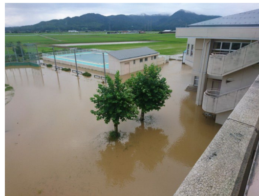
大雨による浸水被害
