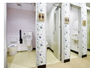
洋式化、乾式化された安全で清潔なトイレ
