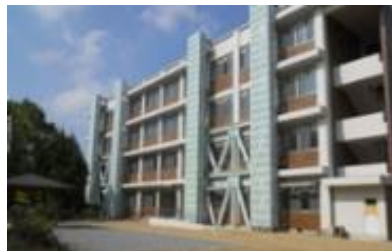
老朽改善された施設
