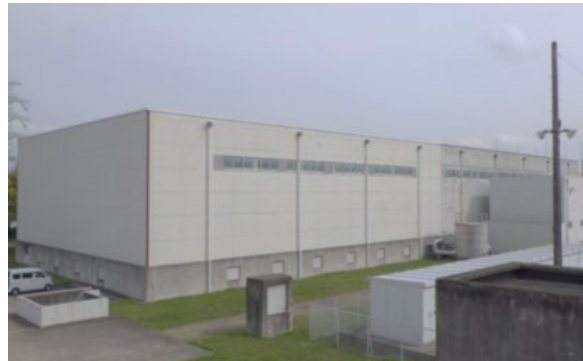
JT-60一次冷却棟
