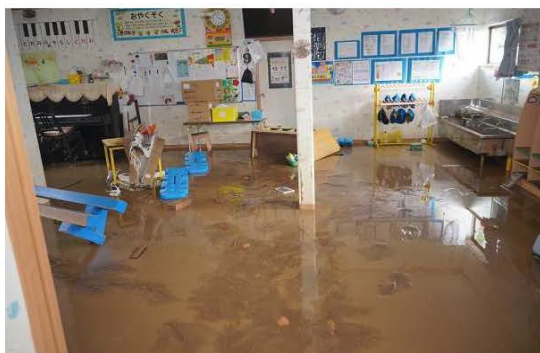
建物内への浸水
