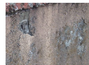
▲ 塗装老朽化によるひび割れや鉄筋腐食等により、コンクリート内部が破裂したもの。
