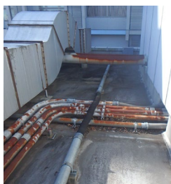
老朽化した空調設備配管、建物外壁クラック
