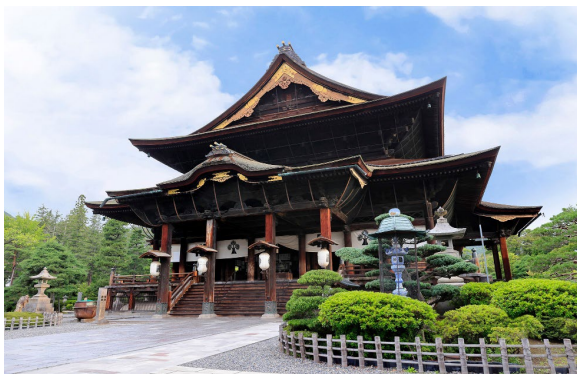
国宝 善光寺本堂 (長野県長野市)
