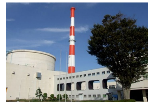
高速実験炉「常陽」
