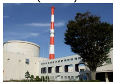
高速実験炉「常陽」
