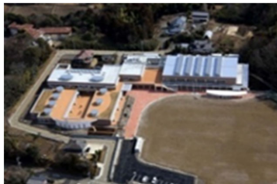
小学校の改修事業
