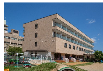
宿舎棟（複合施設）
