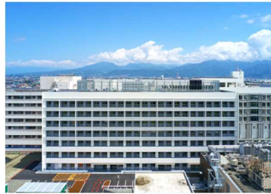
【新病棟Ⅱ期 外観】
