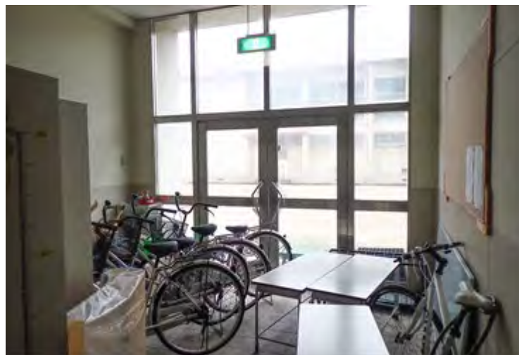
写真 26 避難口の避難の支障となる可能性のある物件（学校 D）
