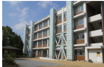
老朽改善された施設
