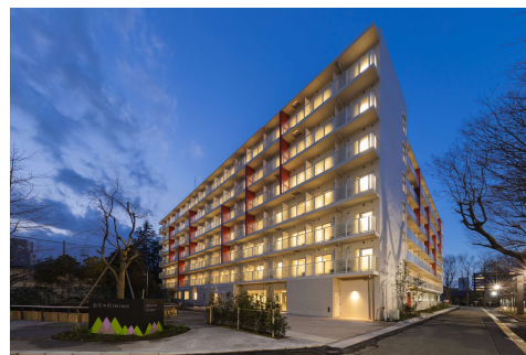
土地貸付収益等を原資に国際寮の建設・運営
