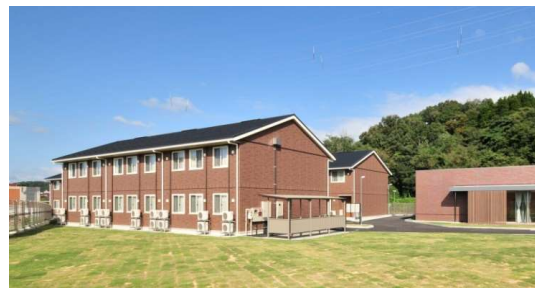
留学生宿舎・多目的棟を整備
