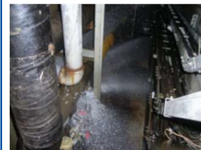
配管の破損による水漏れ
