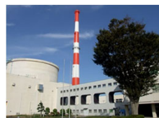
高速実験炉「常陽」
