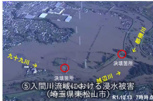
【令和元年東日本台風】
