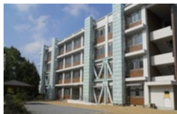
老朽改善された施設
