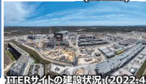
ITERサイトの建設状況 (2022.4)
