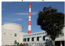
高速実験炉「常陽」
