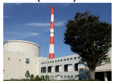
高速実験炉「常陽」
