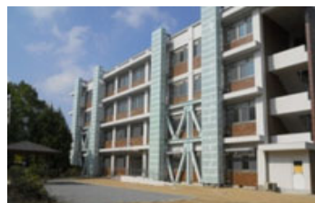
老朽改善された施設
