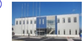
廃炉環境国際共同研究センター（CLADS）「国際共同研究棟」
