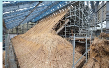
<建造物解体修理の様子> 重要文化財 天徳寺本堂ほか2棟（秋田県）
