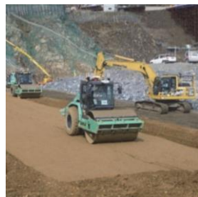
【盛土材の遮水性を施工しながらリアルタイムに遠隔確認】
