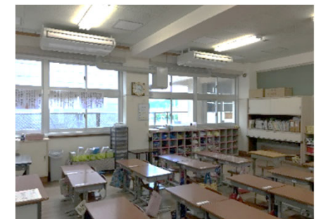
空調設備・換気設備を備えた教室
