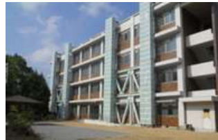
老朽改善された施設
