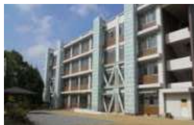
老朽改善された施設
