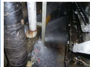
配管の破損による水漏れ
