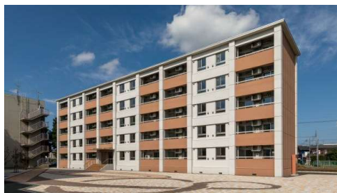
職員宿舎を改修し、留学生宿舎を整備
