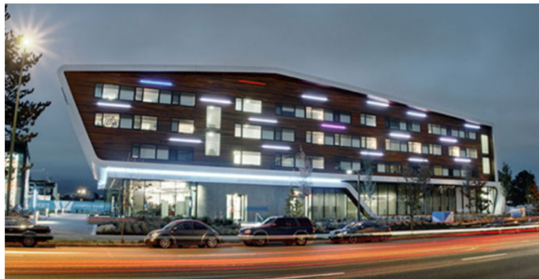
下層にデジタルメディア関係のスペース等の学習施設が入る学生寮 (カナダ・ブリティッシュコロンビア大学 デジタルメディアセンター)
