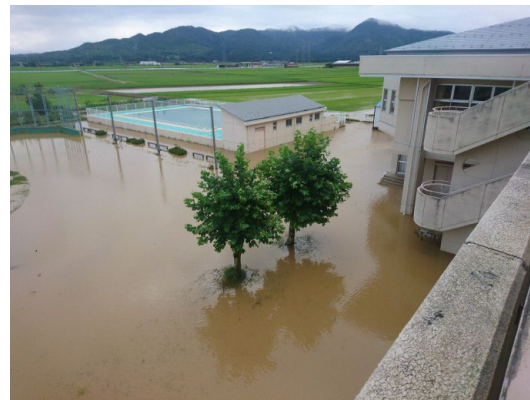
大雨による浸水被害
