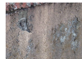
▲ 塗装老朽化によるひび割れや鉄筋腐食等により、コンクリート内部が破裂したもの。
