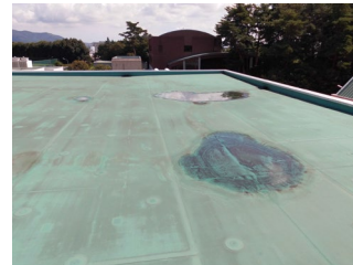
雨水浸入の構造体への影響が懸念される屋上部
