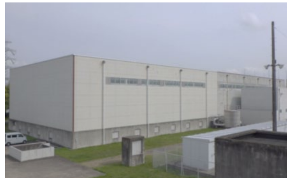
JT-60一次冷却棟
