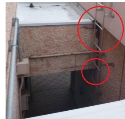
▲ 塗装老朽化によるひび割れや鉄筋腐食等により、コンクリート内部が破裂したもの。
