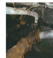
○給排水衛生設備
