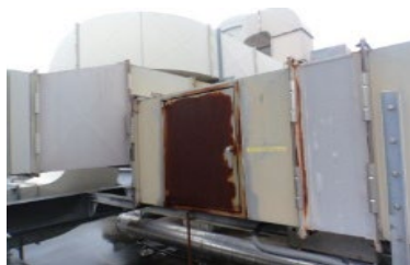
老朽化した空調・電気の各種設備
