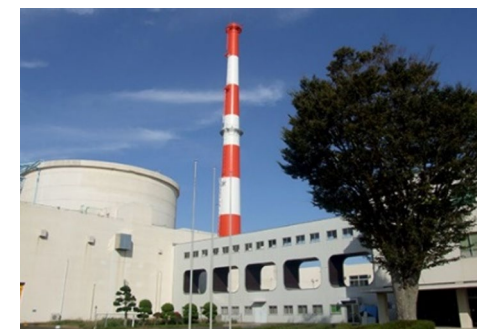
高速実験炉「常陽」
