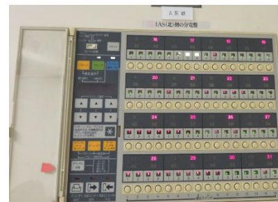
老朽化した照明制御システム
