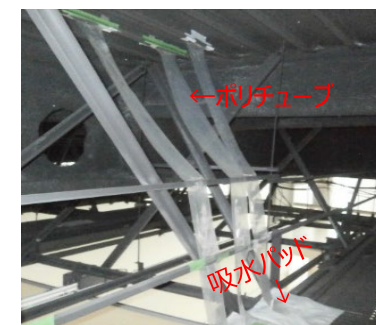
シーリング材劣化による雨漏り
