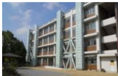
老朽改善された施設
