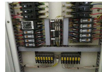
老朽化した照明制御システム
