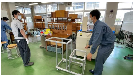
搬送機のフレームの製作
