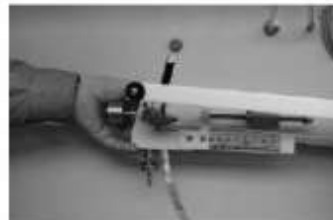
図 4.12 バランス線を支える様子
