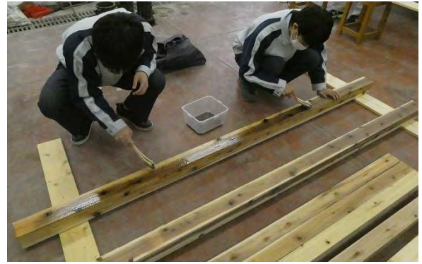
図16 塗料を塗っている様子
