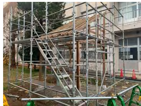
写真2 柱の組立て完了後
