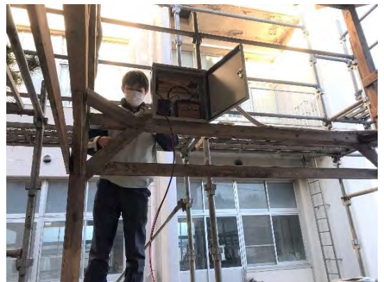
図 2 6 配線を行っている様子
