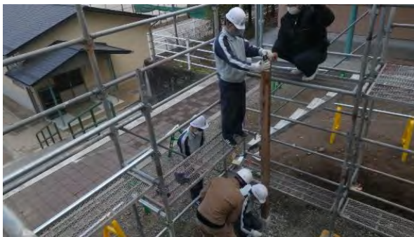
写真1 柱の設置
