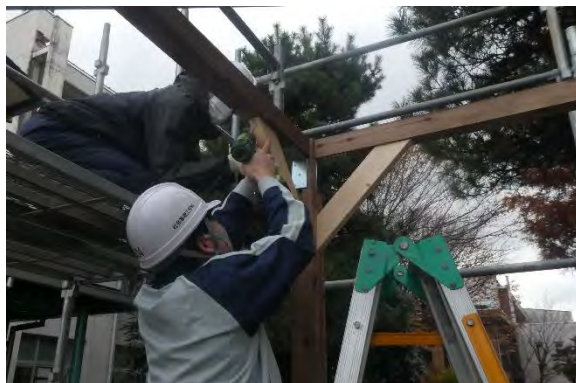
図20 補強している様子
