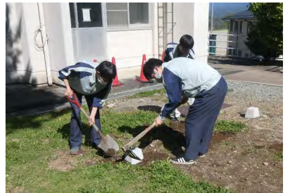
図17 沓石を埋めている様子
