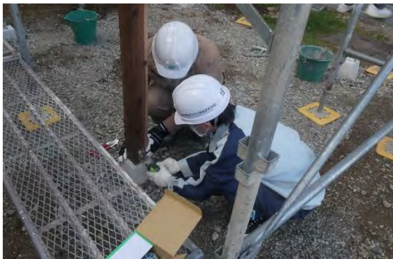
図19 柱を固定している様子
