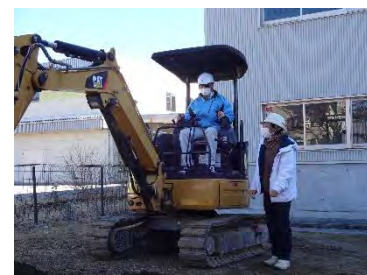
写真3 重機操作技術の伝達
