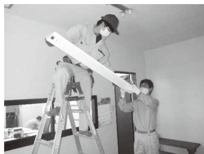
LED取替え工事
