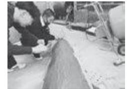
※骨組みがコンクリートから撤去しやすいよう、側面に養生テープを貼った。
