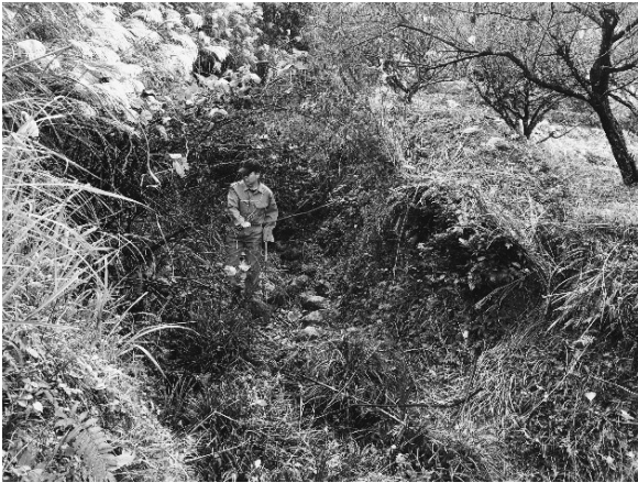
図③水路の石披露で修復作業の様子
