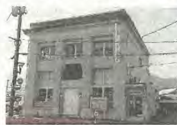
銀行店舗跡のエンターウェ。1階に金庫室がある
