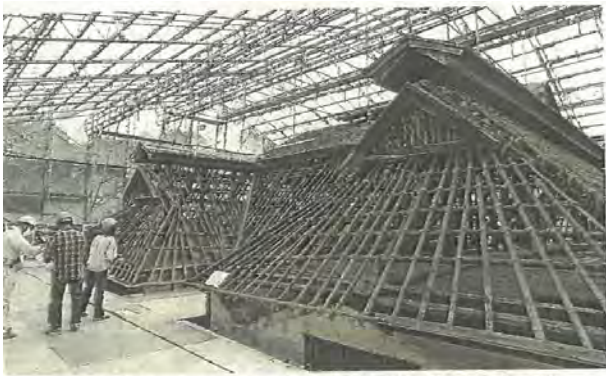
屋根の骨組みを見学する参加者
