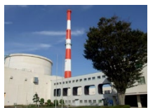
高速実験炉「常陽」
