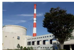
高速実験炉「常陽」
