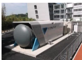
産業用燃料電池実証機（250kw級）
