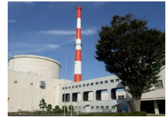
高速実験炉「常陽」
