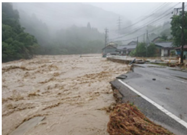
万江川の氾濫により滑落した県道
