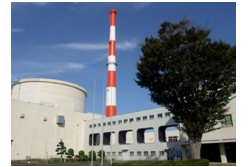
高速実験炉「常陽」
